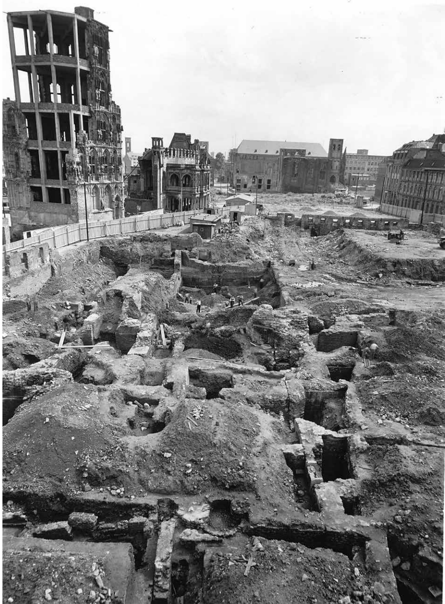
Figure 3. Rathausplatz (beneath the present-day Spanischer Bau): excavation of the Roman governor's palace, 1953 (Rheinisches Bildarchiv).
