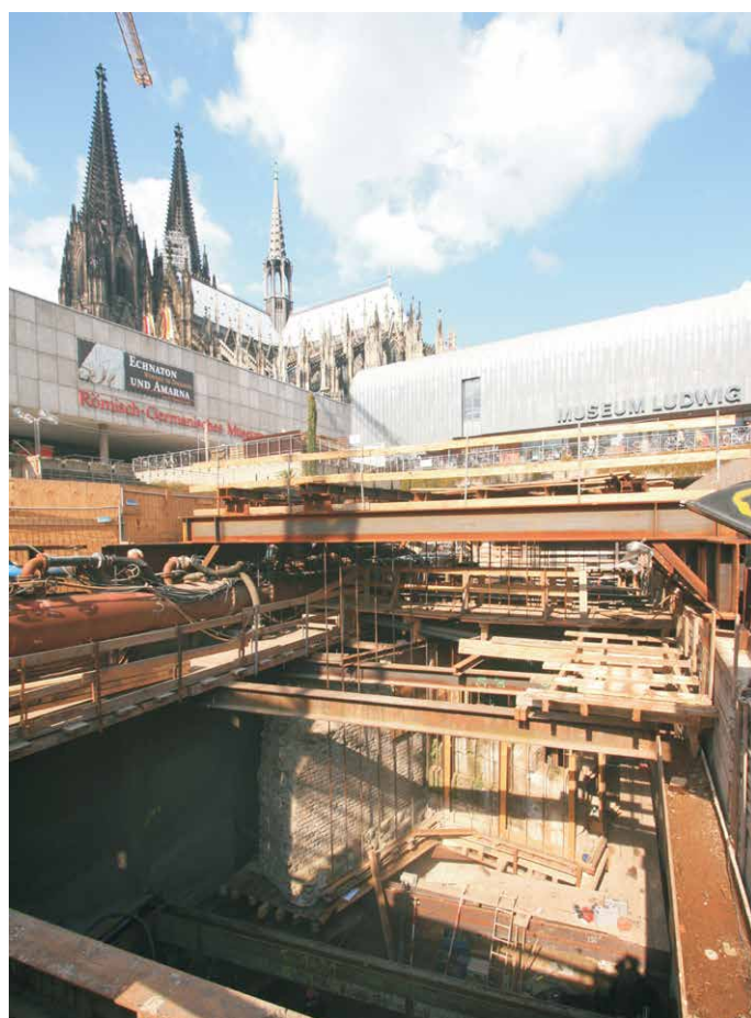
Figure 6. Kurt-Hackenbergs-Platz, Cologne. Permanent preservation of a large section of the Roman city wall (Römisch-Germanisches Museum der Stadt Köln / Arge KölnArchäologie).
