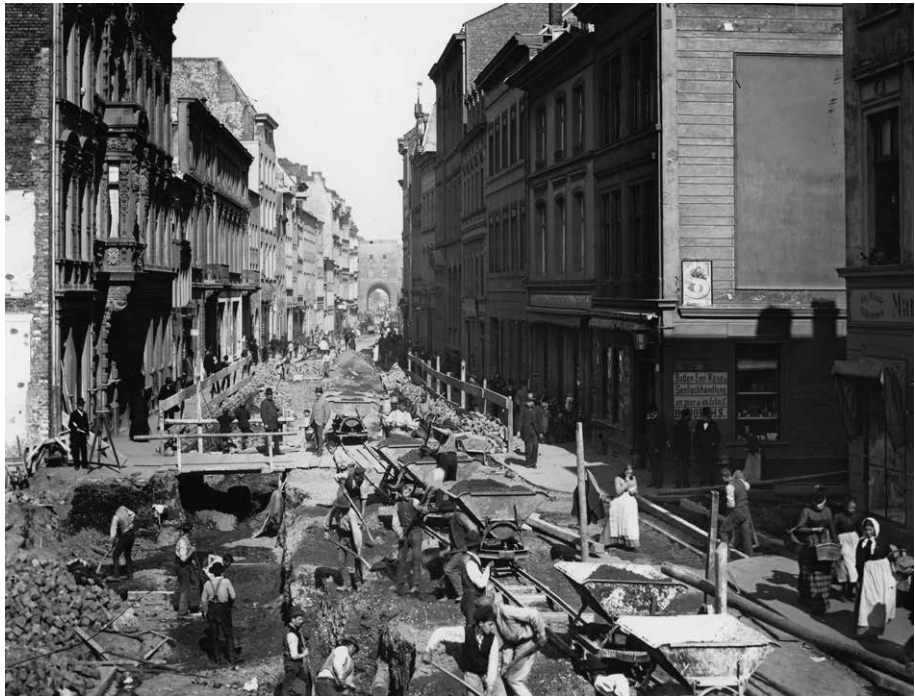
Figure 2. Construction of sewers on Eigelstein, Cologne, c. 1890 (Rheinisches Bildarchiv).
